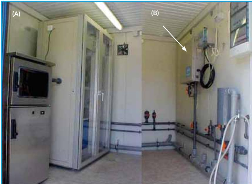
**Figura 89.** Vista interna do container de uma Estação Automática de Monitoramento: (A) Em primeiro plano o amostrador automático refrigerado e, ao fundo, o gabinete onde estão instalados o CLP e os medidores de pH, OD, temperatura e condutividade elétrica; (B) Turbidímetro (Foto: Luis Altivo Carvalho Alvim/CETESB).
