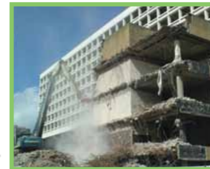
Monitoramento de demolições
